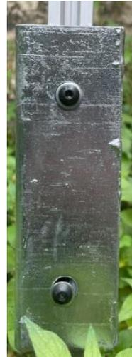
Photos 4 et 5 : Photos des deux rondelles et des deux vis M5x8 à visser pour fixer le dispositif au pieu de fondation
