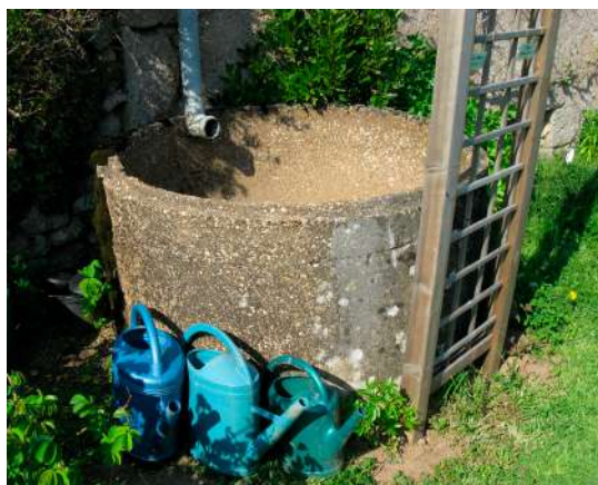
Photo 18 : cuve de récupération d'eau de pluie
