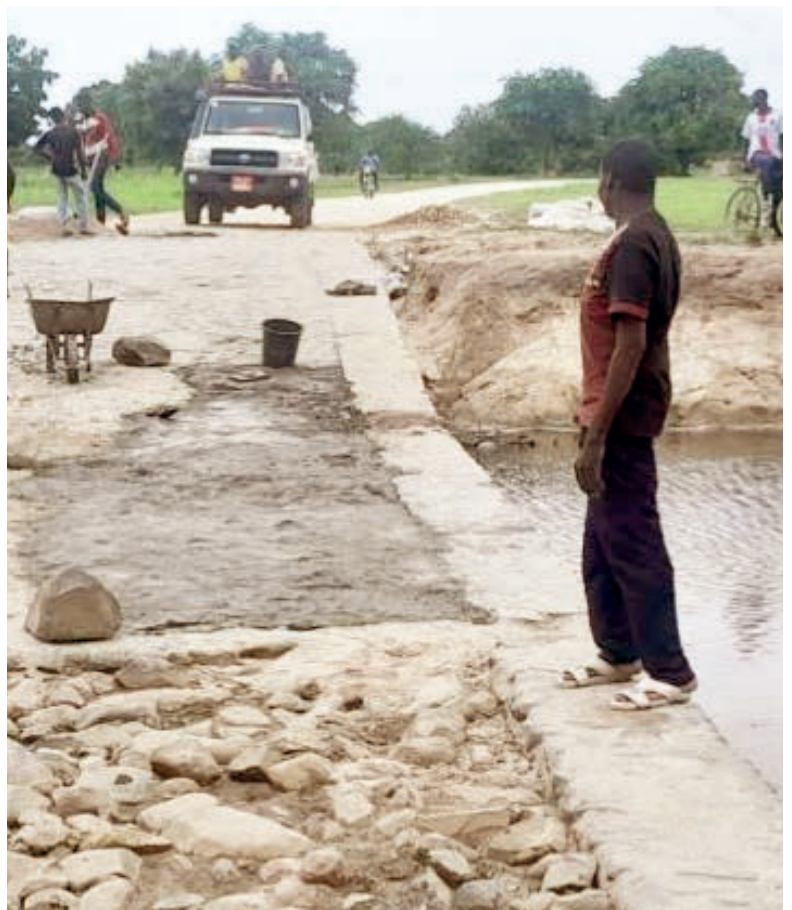
Travaux en cours pour la réfection du radier de Ribao
